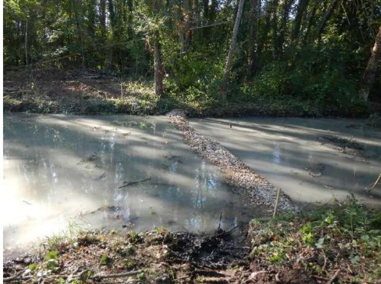
Figure 5 : Exemple de filtre anti-MES
