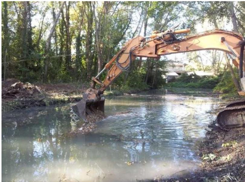
*Figure 14: Mise en place du cordon de banquette.*
